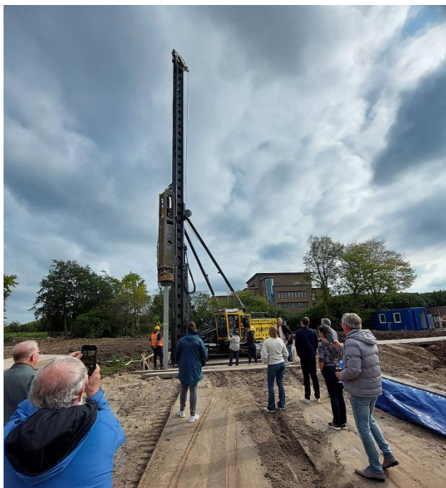
Het heien van de laatste paal
