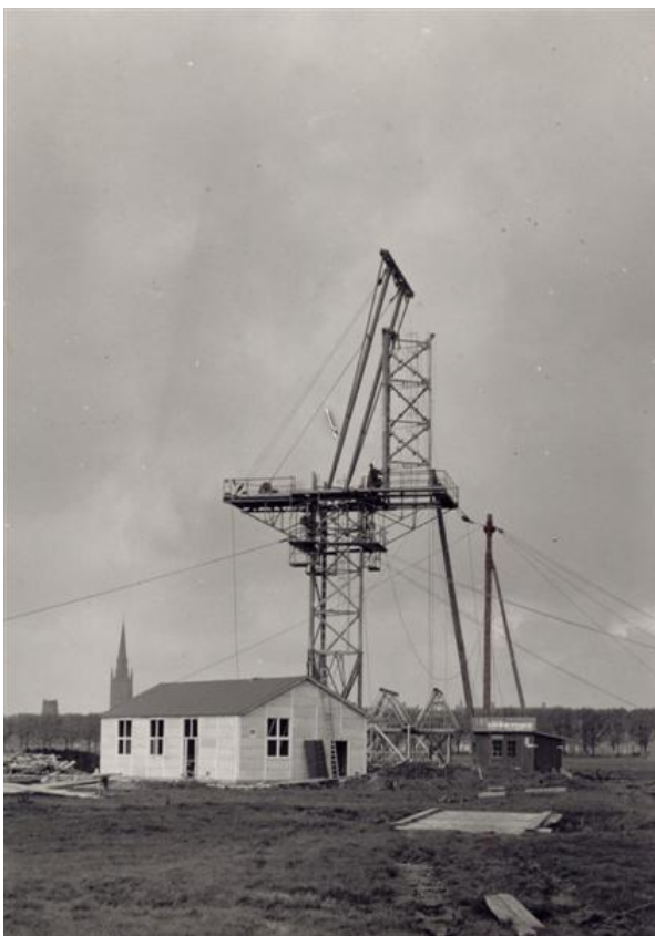
Het gebouwtje met de mast in aanbouw
