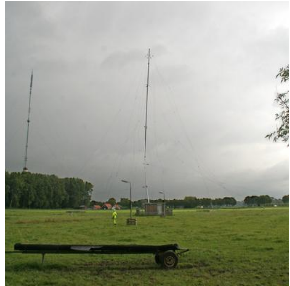
De 80 meter buismast valt neer nadat de man in de gele kleding het touw heeft doorgeknipt. Links is de mast van de TV toren te zien.
