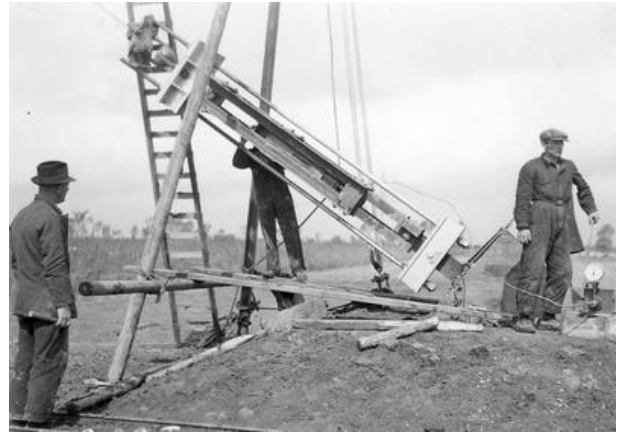
Op een hoogte van 60 meter worden de eerste tuien aangebracht. Daarvoor werd de mast door hulptuilen overeind gehouden.
