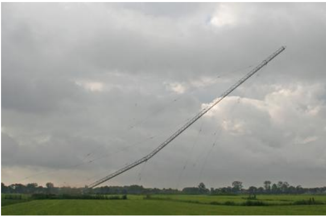
De mast knikt ter hoogte van de onderste tuien
