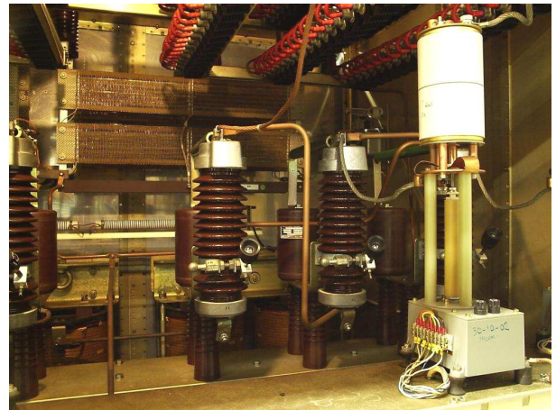
Hoogspanning gelijkrichter
